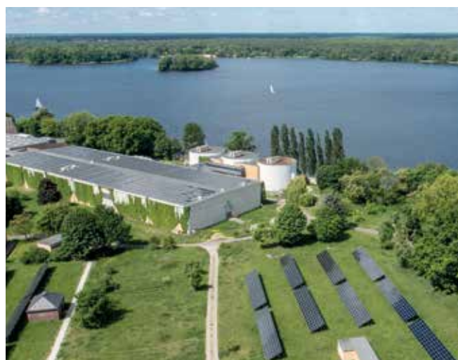
In unserem Wasserwerk Tegel steht die größte zusammenhängende Solaranlage Berlins.
